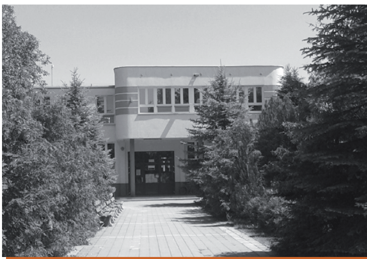
Fot. 3 Zespół Szkół Samorządowych w Rejowcu Fabrycznym został poddany termomodernizacji, co znacznie zmniejszyło zużycie energii ciepłej w budynku (źródło: InE)
