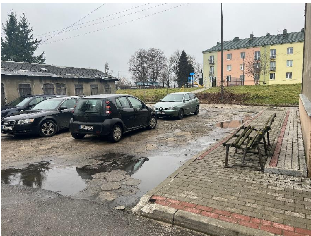
Zdjęcie 12. Ul. Chełmska – przestrzeń publiczna w złym stanie technicznym w bezpośrednim sąsiedztwie zabudowy wielorodzinnej.
