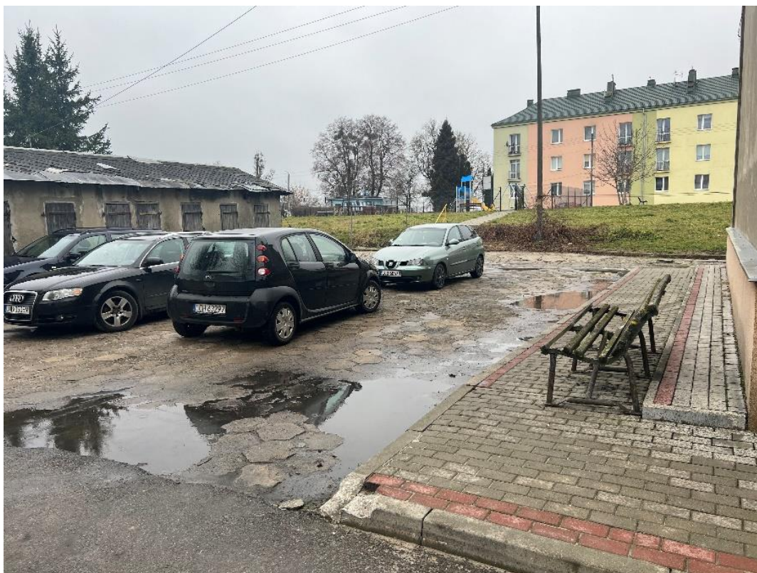
Zdjęcie 12. Ul. Chełmska – przestrzeń publiczna w złym stanie technicznym w bezpośrednim sąsiedztwie zabudowy wielorodzinnej.
